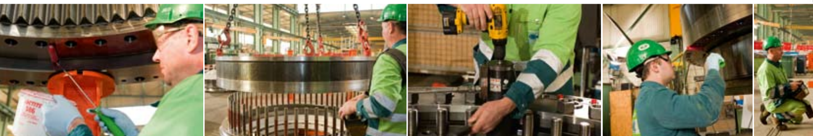
Bei der Montage des Hauptantriebs einer Tunnelbohrmaschine werden nicht weniger als vier große Getriebeteile miteinander verklebt und verschraubt. Loctite® 586 wird dabei mit einer Walze flächig auf die Flanschflächen aufgetragen und erhöht den Reibwert der Verbindung um das 2- bis 2,5-Fache.
